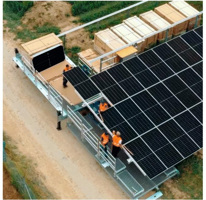
MONTAGE 2.0 im Einsatz: Die Belegung erfolgt von der Seite her – die Solarmodule werden als „ganzer Tisch“ auf Rollen weitergeschoben.
